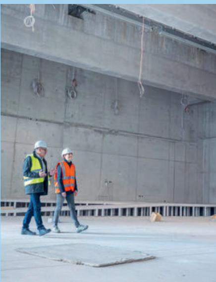
Hier besichtigen der Rektor und die Prorektorin den Rohbau der Aula.
