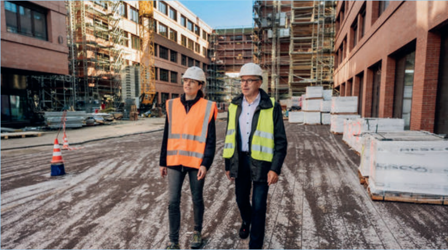
Besichtigung der Baustelle Ende 2025: Prorektorin Prof. Dr. Constanze Stiefel und Rektor Prof. Christof Wolfmaier beim Gang durch den Innenhof.
