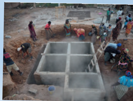
Bau des Toilettentanks (Projekt Saaba Garden Market, 2023)
