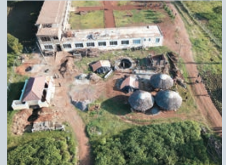
Luftansicht beim Bau der Wasserzisternen (2018)
