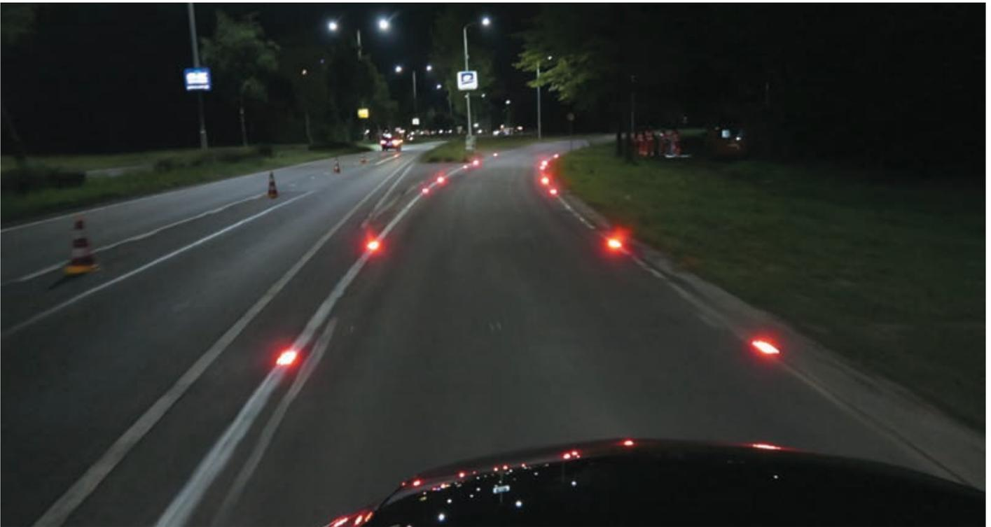
Blick aus dem Fahrzeug auf den Infrastructure Driver Nudge: Lichter leuchten zielgerichtet auf, wenn ein Fahrzeug zu schnell in die Ausfahrt fährt, und „nudgen“ den Fahrer zu einer angemesseneren Geschwindigkeit.
