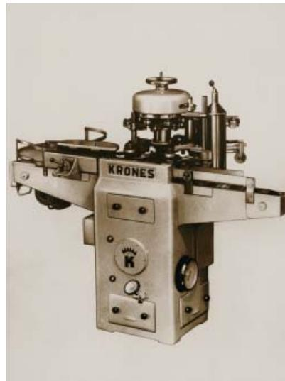
Die erste vollautomatische Etikettiermaschine stellte Krones 1956 vor: die „Super“. Der „aufrechte Gang“ der Flaschen in der Maschine brachte den Durchbruch in den höheren Leistungsbereich.
