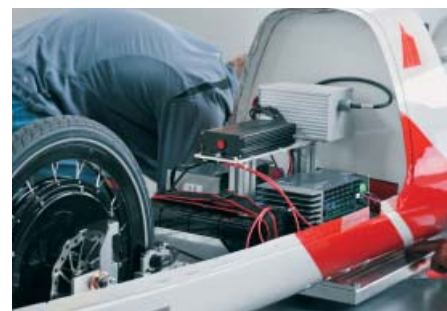
Bei der Montage des Abnehmers auf der Unterseite des Fahrzeugs
