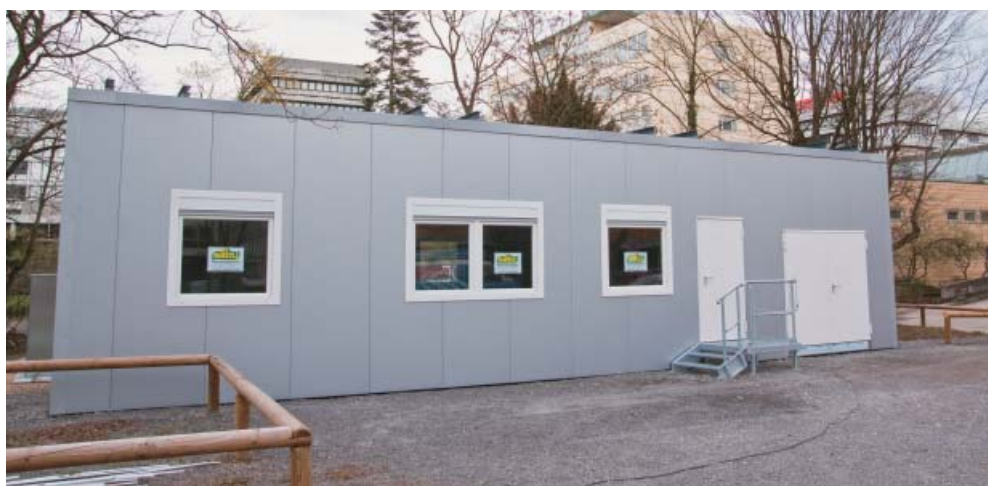
Im Bau: Das „Smart Home“ auf dem Gelände des KIT. (Foto: Gabi Zachmann)
