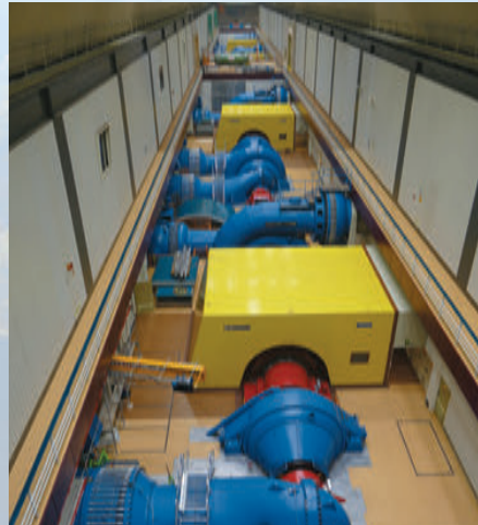
Das Kavernenkraftwerk Wehr zählt mit einer Leistung von 910 MW zu den größten Pumpspeicherkraftwerken in Europa.
