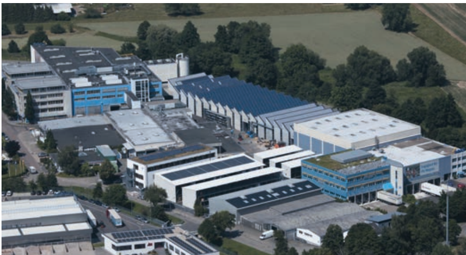
Der Hauptsitz der Schöck Bauteile GmbH befindet sich in Baden-Baden. Foto: Schöck Bauteile GmbH
