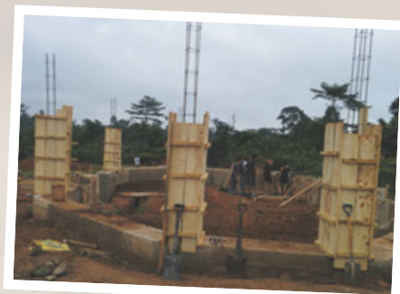
Die Baustelle nach ca. vier Wochen
