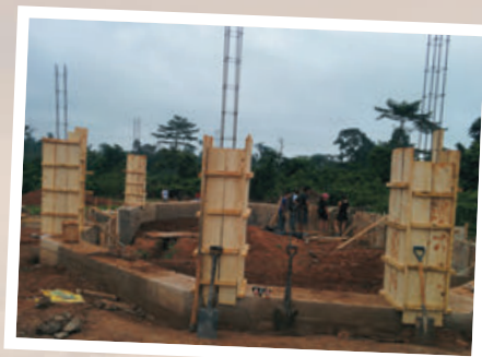
Die Baustelle nach ca. vier Wochen
