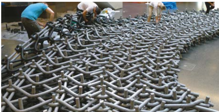
Studierende bauen den temporäre Forschungs- und Ausstellungspavillon auf Bildquelle: FRA-UAS
